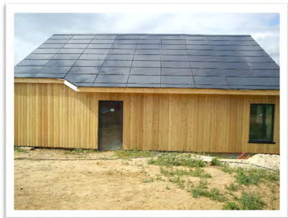
Fig. : Installations de systèmes esthétiques en modules de petites dimensions. Photo de gauche : Damien Jacquinet/SolarStyl® _Photo de droite: France Watt/Mégaslate
